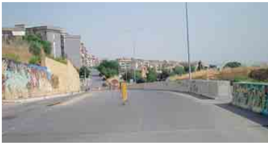
VIALE GAETANO COSTA DOVE (A CANTIERE APERTO) SI VERIFICÒ IL TRAGICO INCIDENTE
