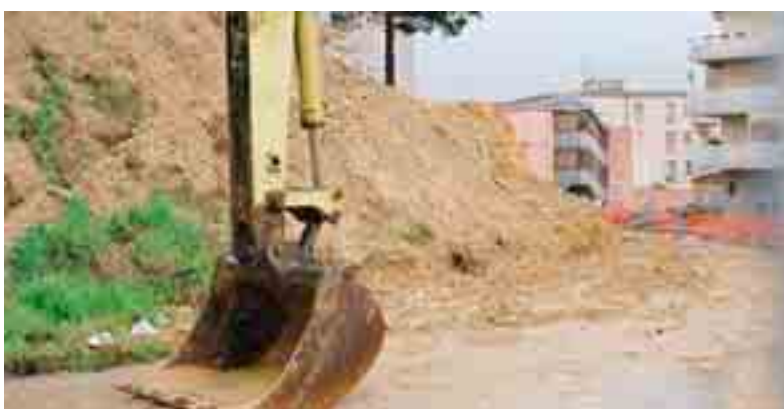
LAVORI DI SBANCAMENTO IN VIA AMICO VALENTI
